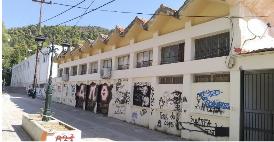
Εικόνα 3 Όψη του ισόγειου κτιρίου στο νότο.
