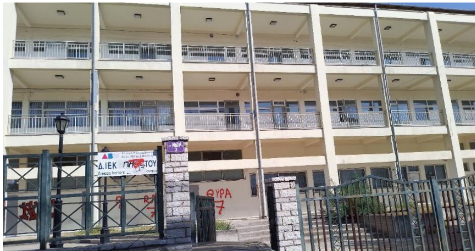
Εικόνα 2 Όψη του τριώροφου κτιρίου στο νότο.
