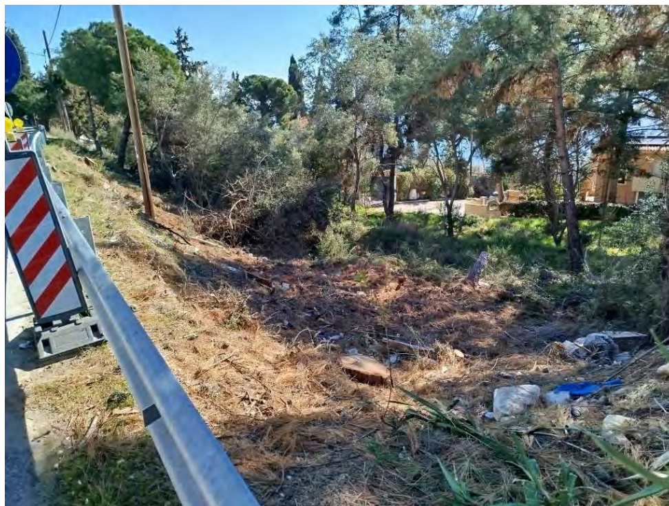
Κοπή δέντρων - προετοιμασία για κατασκευή τοιχείου
