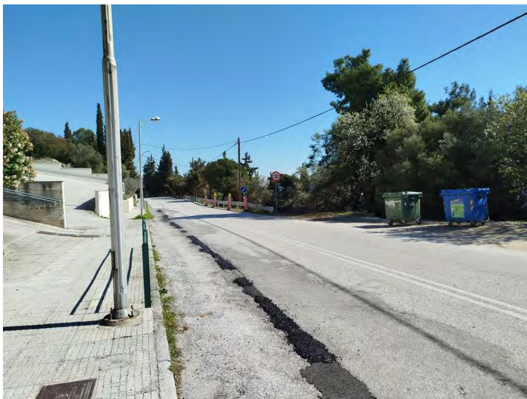
Προσωρινή αποκατάσταση με ψυχρή άσφαλτο
