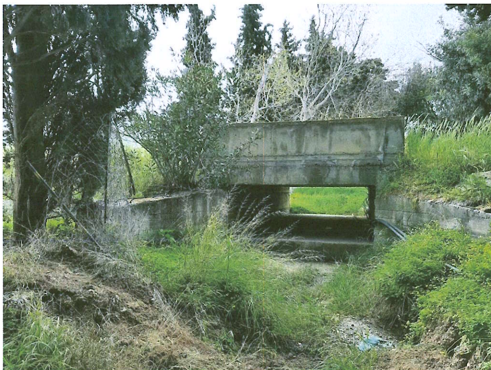
Εικόνα 0.2 : Άποψη τεχνικού T1 επαρχιακής οδού από τα κατάντη
