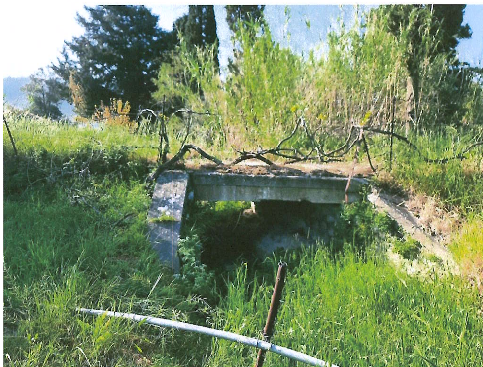
Εικόνα 0.3 : Άποψη οχετού T2 από τα κατάντη
