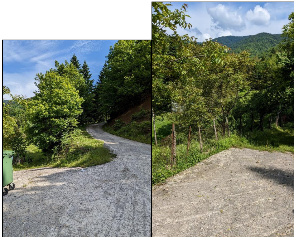
Φωτογραφία 7, 8: Άποψη χώρου ηλεκτροφωτισμού Αγ. Μαρίνας
