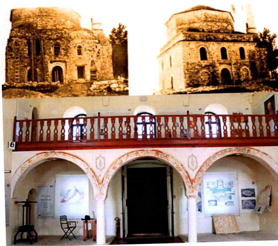
εικ.6 Αναστηλωτικές εργασίες και έκθεση εποπτικού υλικού στο Φετιχιέ τζαμί.
