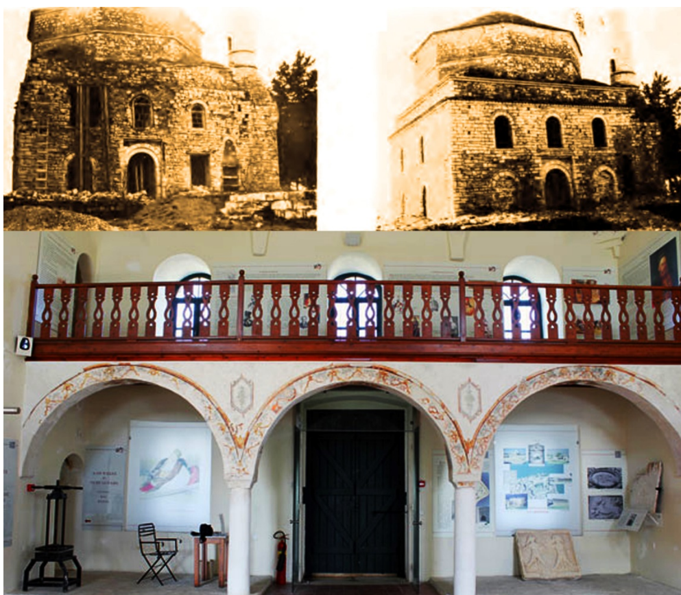
εικ.6 Αναστηλωτικές εργασίες και έκθεση εποπτικού υλικού στο Φετιχιέ τζαμί.
