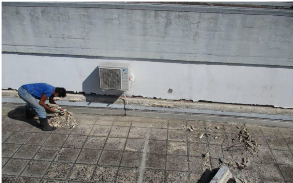
Εικόνα 16: Άποψη του ΒΔ' τμήματος του δώματος – Διακρίνονται οι εργασίες επισκευής της υγραμόνωσης.
